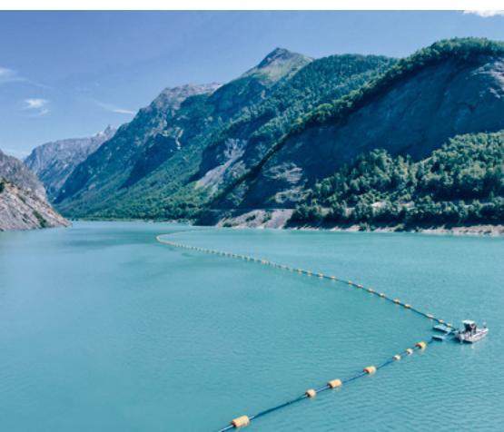
étaient poursuivis avec le robot NESSIE®, suivant un profil en demi-cône, avec extraction et refoulement des sédiments à environ 1 km en amont de la prise d'eau. Près de 20 000 m<sup>3</sup> de sédiments ont ainsi été extraits.
